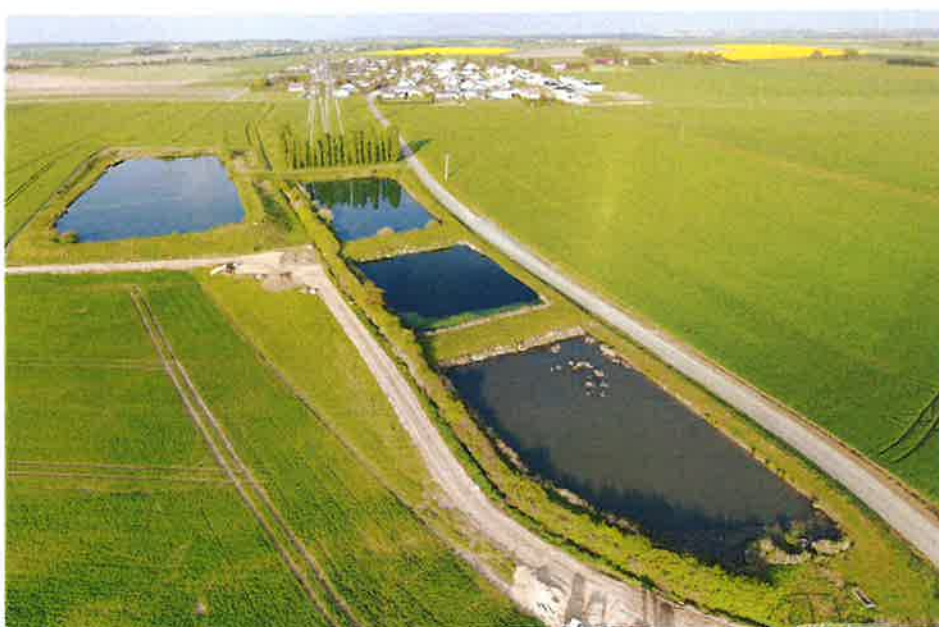
Station d'épuration – Lagune de la commune de Marsilly - Source : communauté de communes Haut Chemin-Pays de PANGE
